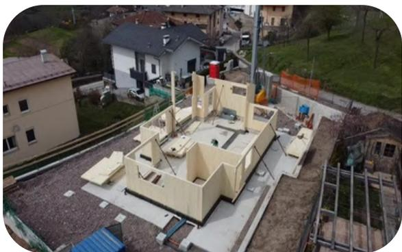
Grazie alla realizzazione di elementi prefabbricati in legno, la costruzione avviene a secco indipendentemente dalle condizioni meteo eliminando le attese e ottimizzando i tempi di realizzazione.
